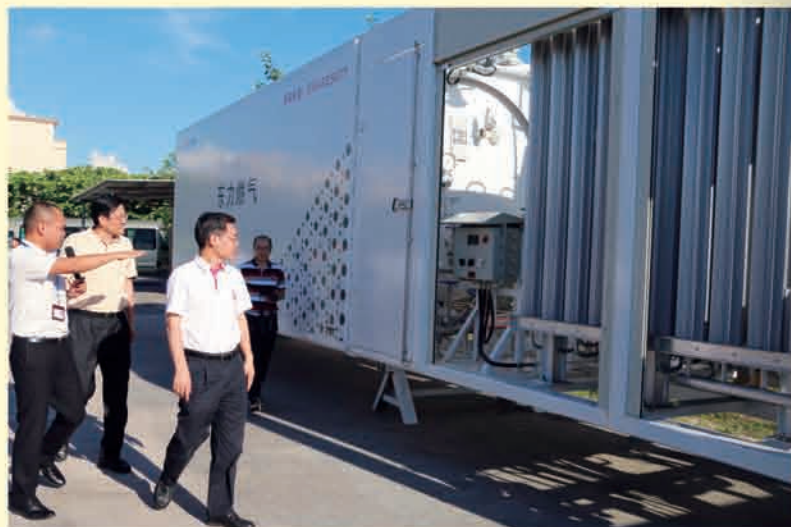
▲ 方灿芬局长参观东力燃气的“一体撬”直供气装置
